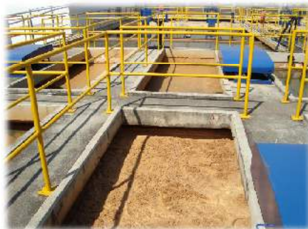
Tanques de floculação
